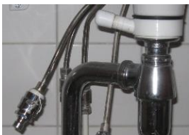
Kuva 3: esimerkkikuva pyykinpesukoneen imusuojasta ja muovitulpasta.
