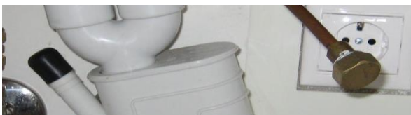
Kuva 1: esimerkkikuva astianpesukoneen messinki- ja muovitulpasta.
