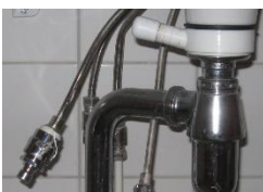
Kuva 3: pyykinpesukoneen imusuojusta ja muovitulppa
