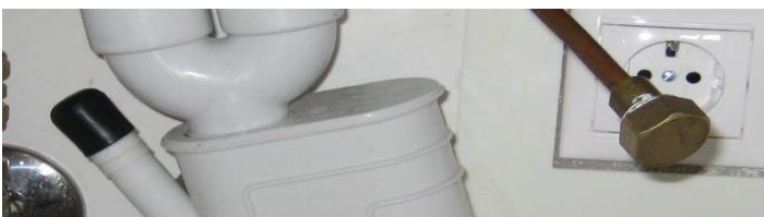
Kuva 1: astianpesukoneen messinki- ja muovitulppa
