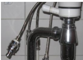
Kuva 3: esimerkkikuva pyykinpesukoneen imusuojusta ja muovitulpasta.
