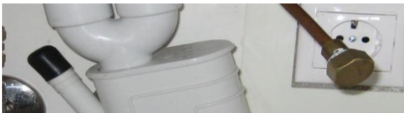
Kuva 1: esimerkkikuva astianpesukoneen messinki- ja muovitulpasta.
